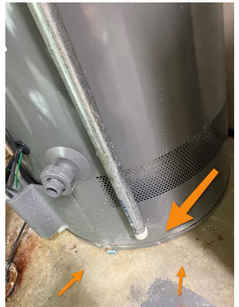
TPR Valve Discharge
